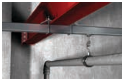
Podwieszenie szyny do dźwigara stalowego
