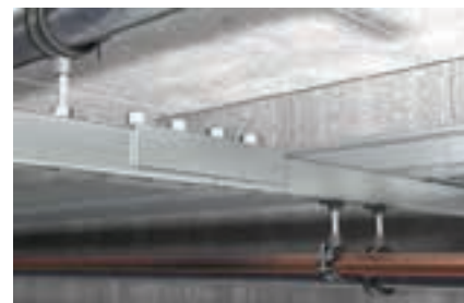
Przedłużenie szyny montażowej
