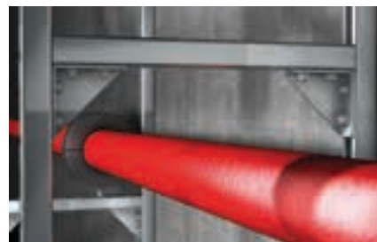
Usztywniona konstrukcja wsporcza
