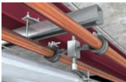
Montaż rurociągów z wykorzystaniem kostki
