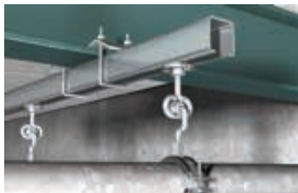
Szyna z elementami przesuwными
