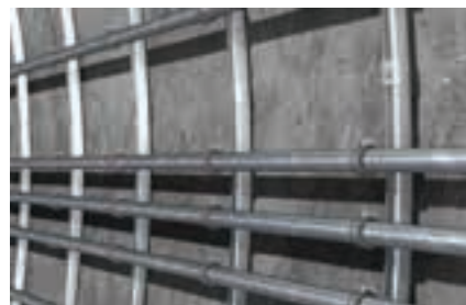
Stabilizacja szyn na ścianie tunelu
