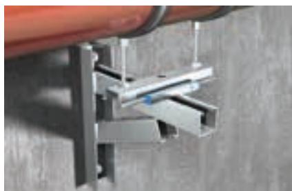
Element przesuwny na wsporniku
