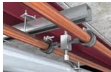
Stabilizacja rurociągów przy pomocy kostki montażowej
