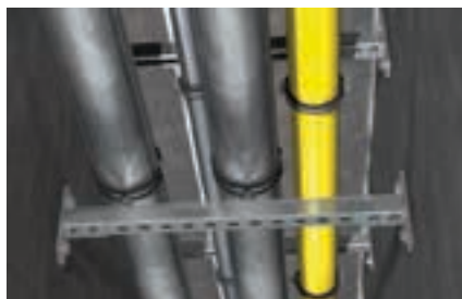
Instalacja rurociągową w drodze ewakuacyjnej
