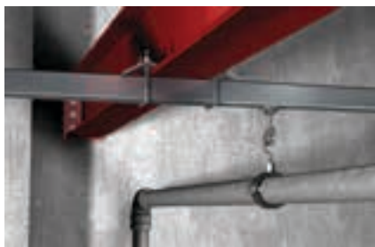
Mocowanie szyny montażowej do dźwigara
