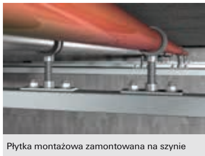
Rura tworzywowa zamocowana w punkcie stałym
