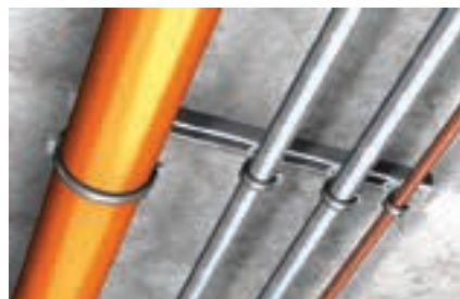
Montaż rurociągów ściękowych
