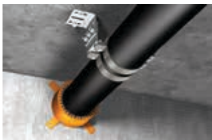
Zamocowanie punktu stałego
