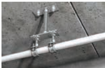
Zamocowanie rury tworzywowej usztywnionej punktem stałym
