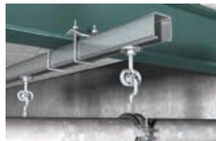
Szyna z podwieszonymi uchwyty ślizgowymi
