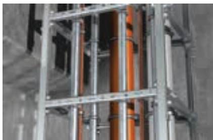
Konstrukcja ramy 3D
