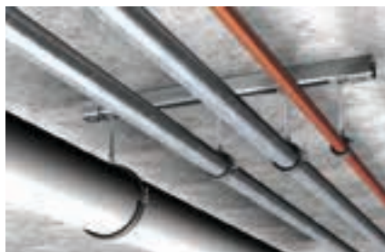
Podwieszenie lekkich rurociągów
