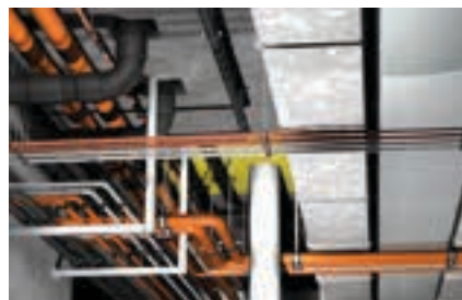
Podwieszenie rurociągów z mediami
