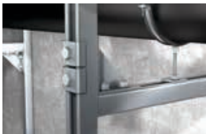
Usztywnione połączenie ramy
