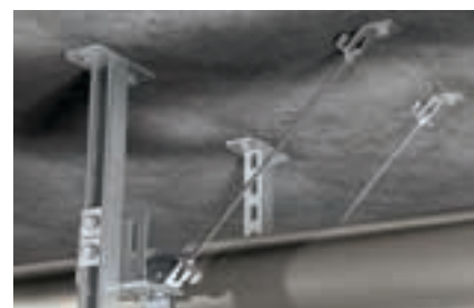
Zamocowanie punktów stałych
