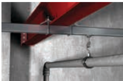
Mocowanie szyny montażowej do dźwigara
