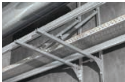
Wsporniki z usztywnieniami
